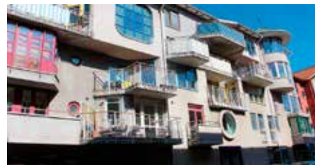
Övre bilden. Urbana Villor i Västra Hamnen. Nedre bilden. Bo100
